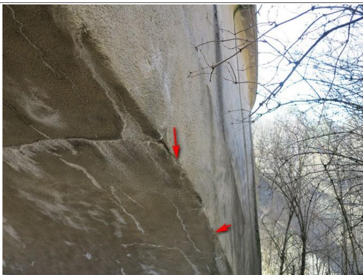
Foto č. 3 K 08 - podélná trhlina na levé hraně
