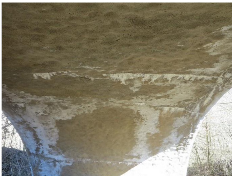
Foto č. 1 K 01 - trhliny s průsaky a výluhy, tvorba krápníků
