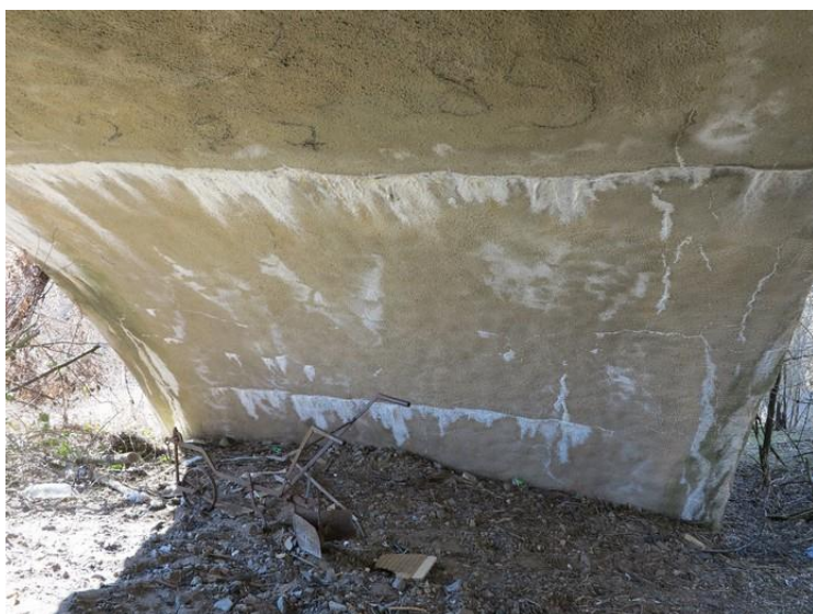
Foto č. 2 K 08 - trhliny s průsaky a výluhy nad P 07
